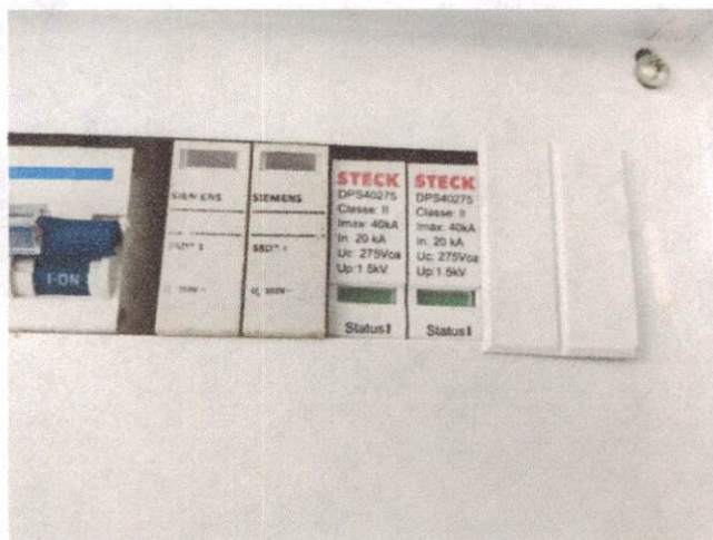
Descrição: DISPOSITIVO DPS CLASSE II, 1 POLO, TENSÃO MÁXIMA DE 275 V, CORRENTE MÁXIMA DE *20* KA (TIPO AC)
