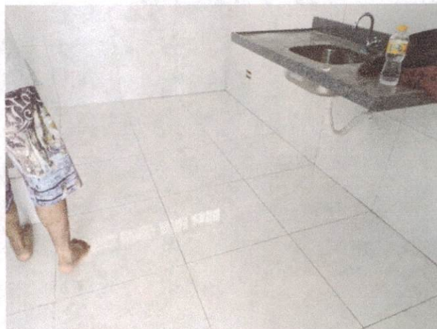
Descrição: LIMPEZA FINAL DA OBRA.
