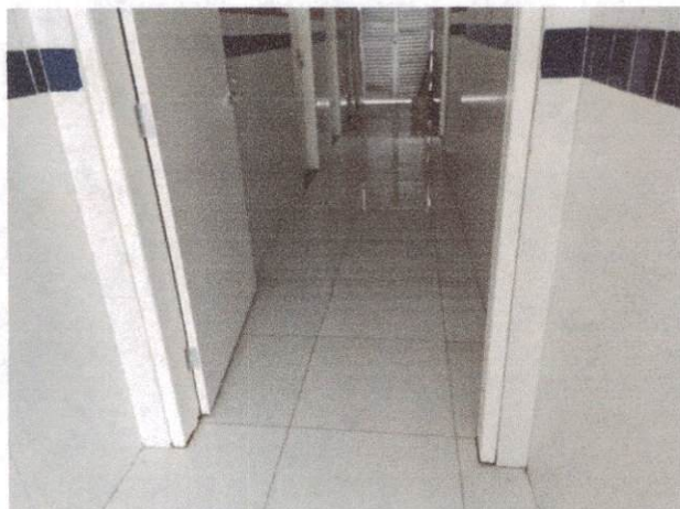
Descrição: LIMPEZA FINAL DA OBRA.
