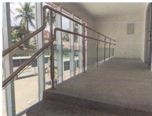
Descrição: VIDRO TEMPERADO INCOLOR, ESPESSURA 10MM, FORNECIMENTO E INSTALACAO.
