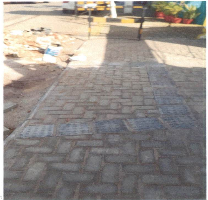
Item: 10.7 PISO PODOTÁTIL DIRECIONAL OU ALERTA DE CONCRETO ASSENTADO SOBRE ARGAMASSA CENTRO DE DESENVOLVIMENTO
