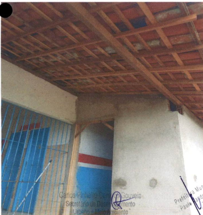
Item: 7.3 TELHAMENTO COM TELHA CERAMICA CAPA-CANAL, TIPO
