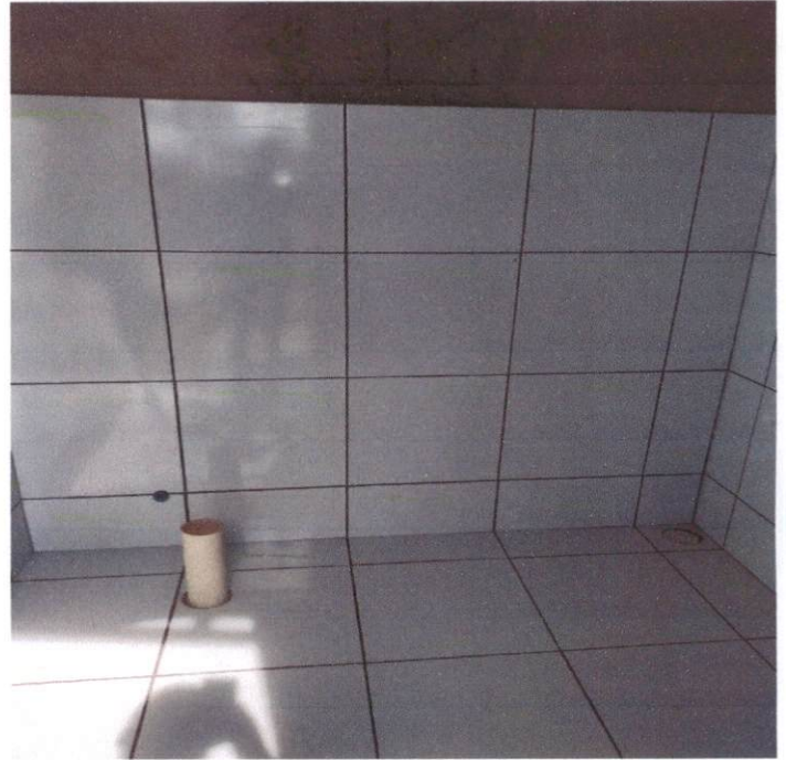
Item: 8.9 ponto de esgoto com tubo de PVC rígido de 100mm (vaso sanitário) ESCOLA ANTONIO MONTENEGRO
