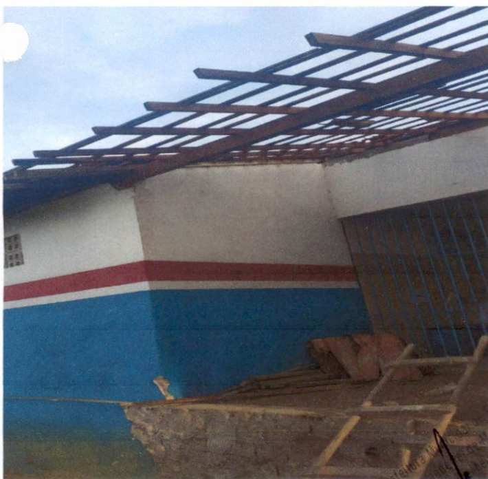
Item: 7.2 TRAMA DE MADEIRA COMPOSTA POR RIPAS, CAIBROS E TERÇAS PARA TELHADOS ESCOLA DO RODRIZIO
