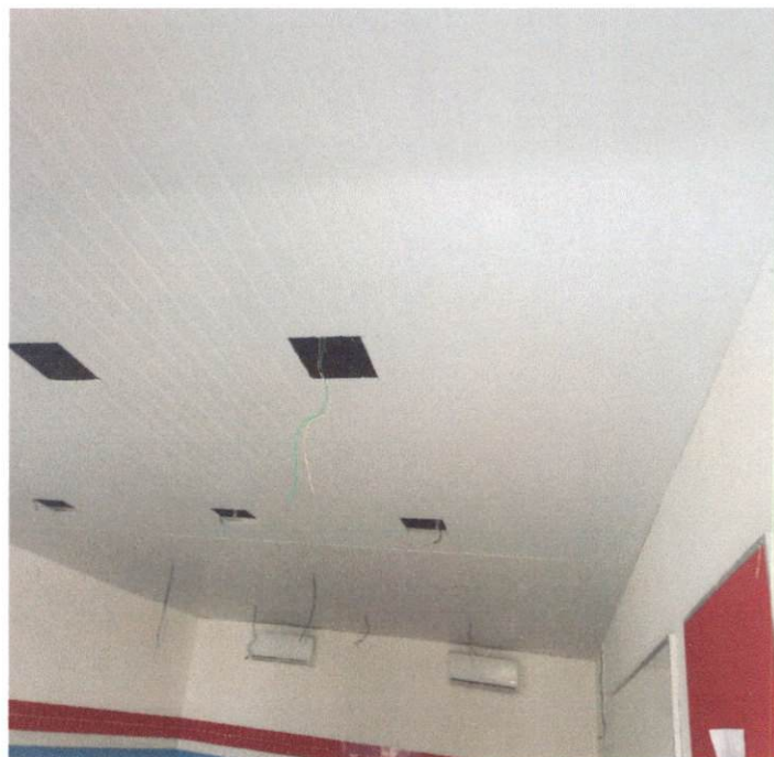
Item: 6.1 FORRO EM RÉGUAS DE PVC, FRISADO, PARA AMBIENTES COMERCIAIS, INCLUSIVE ESTRUTURA DE FIXAÇÃO. AF_05/2017 CMG
