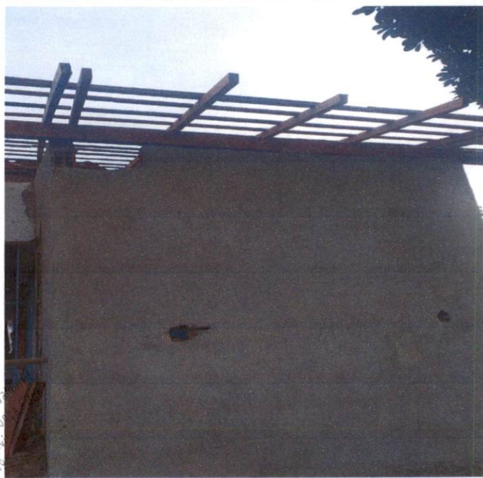
Item: 7.2 TRAMA DE MADEIRA COMPOSTA POR RIPAS, CAIBROS E TERÇAS PARA TELHADOS ESCOLA DO RODRIZIO
