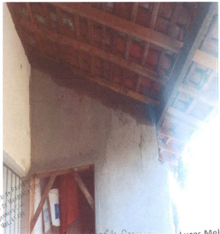
Item: 7.3 TELHAMENTO COM TELHA CERAMICA CAPA-CANAL, TIPO
