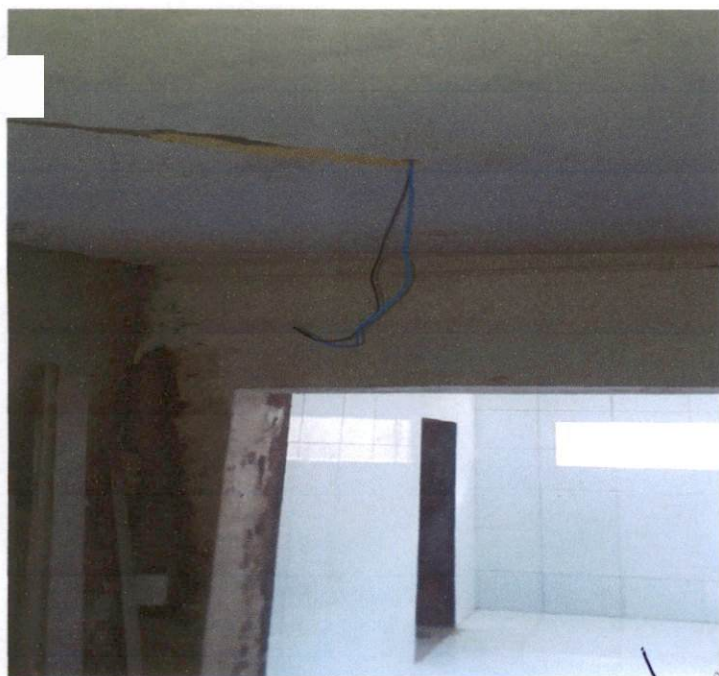
Item: 9.15 PONTO DE ILUMINAÇÃO RESIDENCIAL INCLUINDO INTERRUPTOR SIMPLES,ELETRODUTO,CABO CENTRO DE DESENVOLVIMENTO
