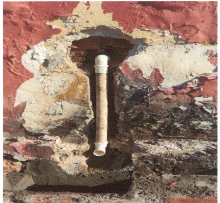
Item: 8.12 JOELHO DE 90 GRAUS PVC SERIE NORMAL ESGOTO PREDIAL ESCOLA JOAO FRANCISCO BEZERRA
