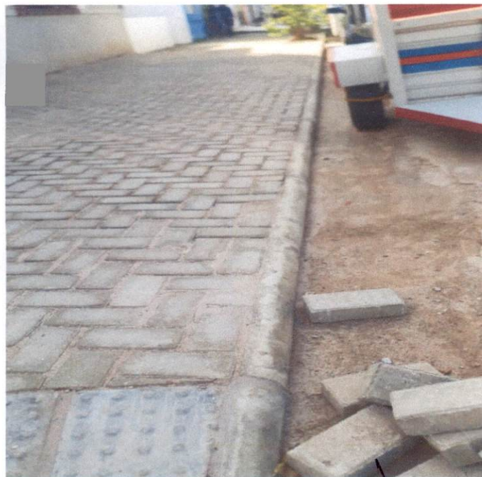
Item: 10.6 ASSENTAMENTO DE GUIA(MEIO-FIO) EM TRECHO RETO, CONFECCIONADA EM CONCRETO CENTRO DE DESENVOLVIMENTO
