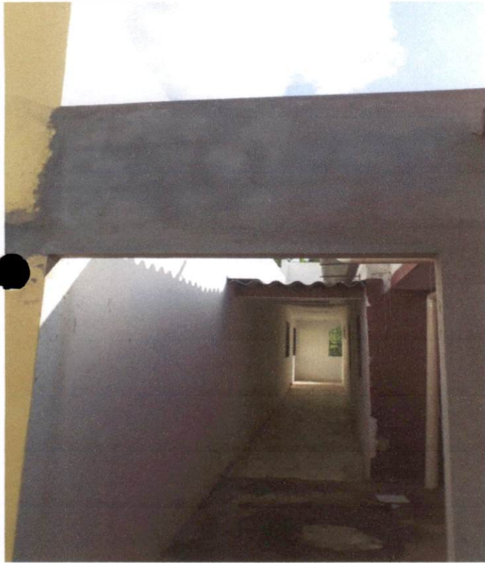
Item: 12.1 VERGA PRÉ MOLDADA PARA PORTAS COM MAIS DE 1,5 M CENTRO DE DESENVOLVIMENTO
