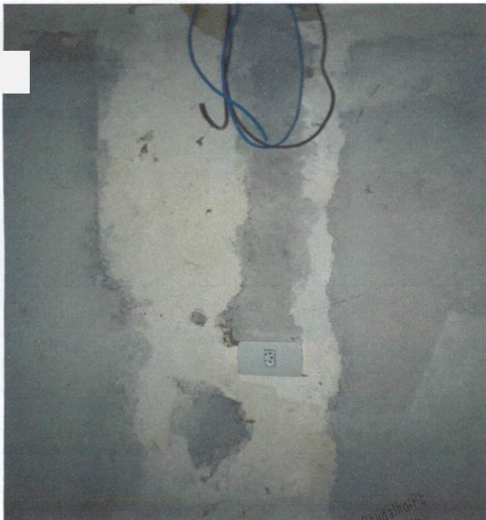
Item: 9.7 TOMADA MEDIA DE EMBUTIR (1 MODULO) CENTRO DE DESENVOLVIMENTO
