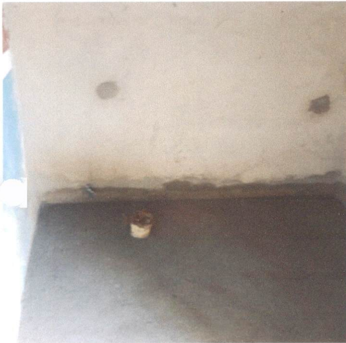
Item: 8.9 ponto de esgoto com tubo de PVC rígido de 100mm (vaso sanitário) ESCOLA DO RODRIZIO
