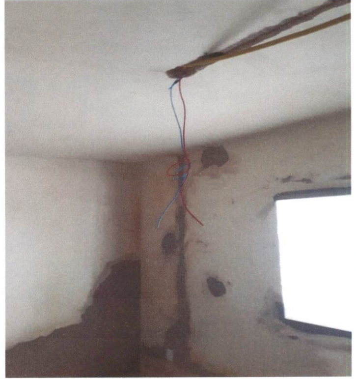
Item: 9.15 PONTO DE ILUMINAÇÃO RESIDENCIAL INCLUINDO INTERRUPTOR SIMPLES,ELETRODUTO,CABO CENTRO DE DESENVOLVIMENTO
