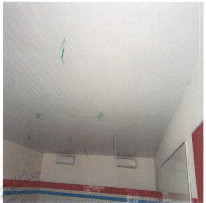
Item: 6.1 FORRO EM RÉGUAS DE PVC, FRISADO, PARA AMBIENTES COMERCIAIS, INCLUSIVE ESTRUTURA DE FIXAÇÃO. AF_05/2017 CMG
