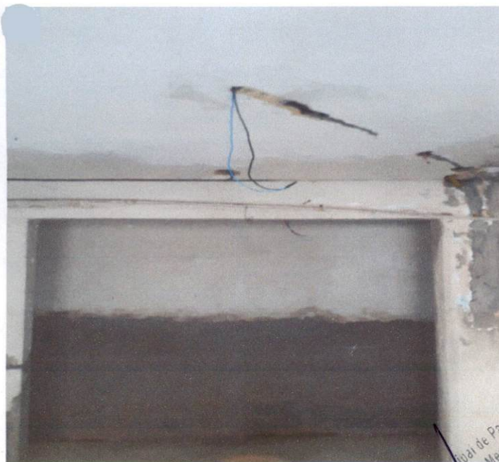
Item: 9.16 PONTO DE ILUMINAÇÃO RESIDENCIAL INCLUINDO INTERRUPTOR SIMPLES,CABO CENTRO DE DESENVOLVIMENTO
