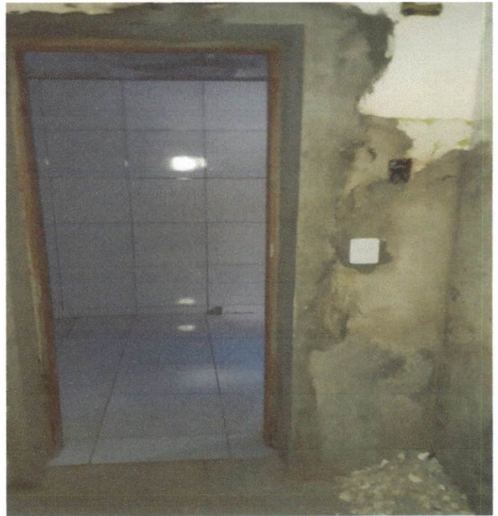
Item: 9.9 INTERROPTOR SIMPLES ( 1MODULO) CENTRO DE DESENVOLVIMENTO
