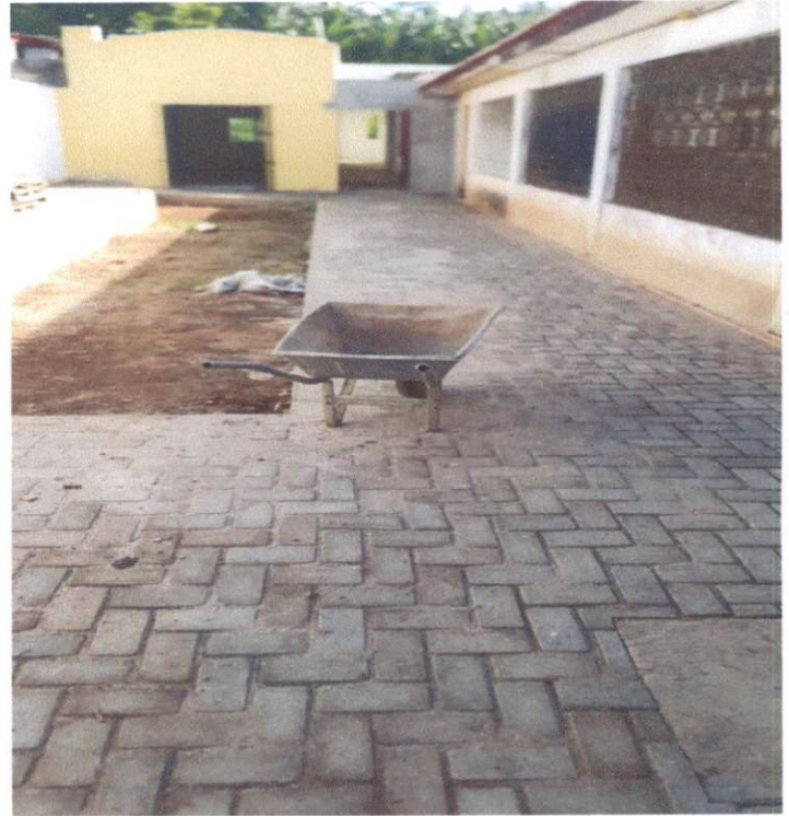
Item: 10.5 EXECUÇÃO DE PASSEIO EM PISO INTERTRAVADO COM BLOCO RETANGULAR COR NATURAL CENTRO DE DESENVOLVIMENTO
