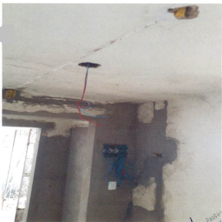
Item: 9.14 PONTO DE ILUMINAÇÃO RESIDENCIAL INCLUINDO INTERRUPTOR SIMPLES CENTRO DE DESENVOLVIMENTO
