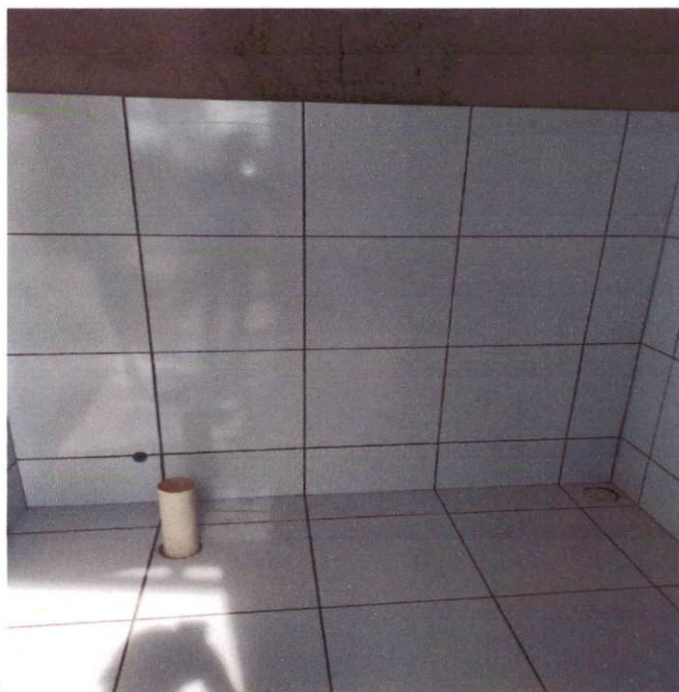
Item: 10.4 RESVESTIMENTO PARA PISO COM PLACAS TIPO ESMALTADA ESCOLA ANTONIO MOTENEGRO
