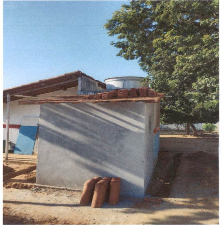
Item: 7.2 TRAMA DE MADEIRA COMPOSTA POR RIPAS,CAIBROS E TERÇAS PARA TELHADOS ESCOLA ANTONIO MONTENEGRO
