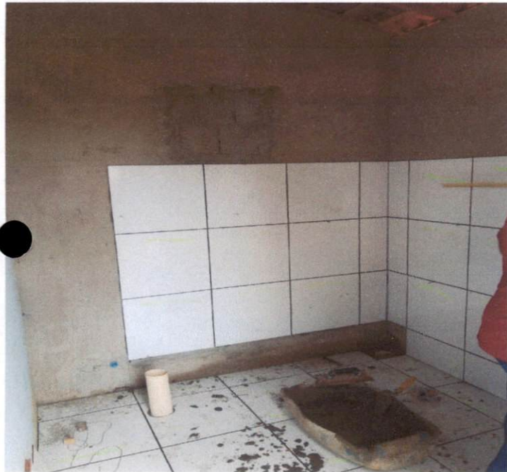
Item: 5.5 REVESTIMENTO CERÂMICO PARA PAREDES INTERNAS ESCOLA RODRIZIO
