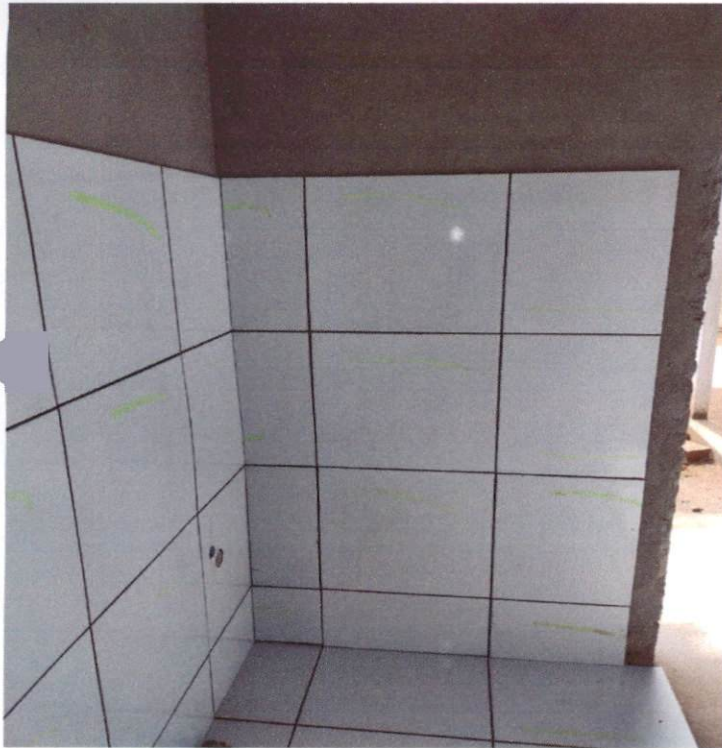
Item: 5.5 REVESTIMENTO CERÂMICO PARA PAREDES INTERNAS ESCOLA ANTONIO MONTENEGRO
