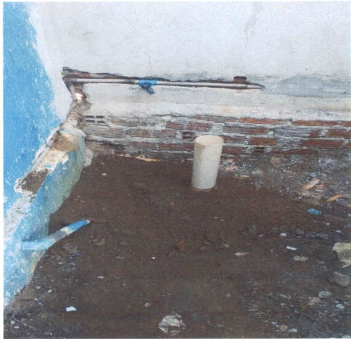
Item: : 8.7 PONTO DE CONSUMO TERMINAL DE ÁGUA FRIA (SUBRAMAL) COM TUBULAÇÃO DE PVC, DN 25 MM 8.8 PONTO DE ESGOTO COM TUBO DE PVC RIGIDO DE 40MM ESCOLA DO RODRIZIO
