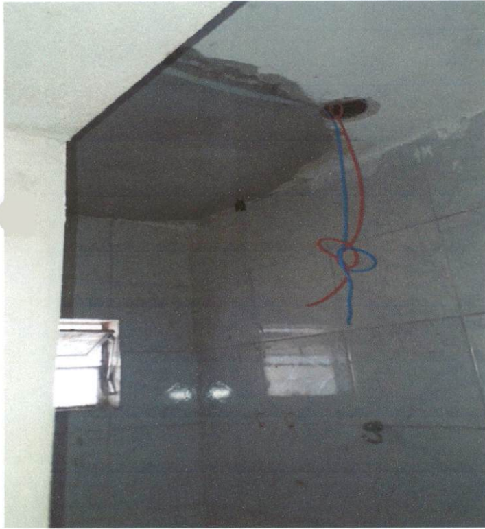
Item: 9.15 PONTO DE ILUMINAÇÃO RESIDENCIAL INCLUINDO INTERRUPTOR SIMPLES,ELETRODUTO,CABO CENTRO DE DESENVOLVIMENTO
