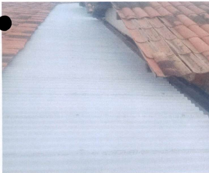
Item: 7.9 TELHAMENTO COM TELHA DE FIBRACIMENTO ONDULADA ESP=4MM ESCOLA ELIZA FIDELIS
