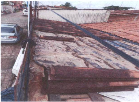
Item: 2.1.1 RETIRADA E RECOLOCAÇÃO DE TELHA CERÂMICA DE ENCAIXE, COM ATÉ DUAS ÁGUAS, INCLUSO IÇAMENTO. AF_07/2019
