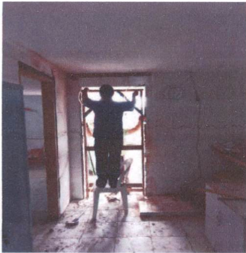
Item: 2.3.1 KIT DE PORTA DE MADEIRA PARA PINTURA, SEMI-OCA (PESADA OU SUPERPESADA), PADRÃO MÉDIO, 80X210CM, ESPESSURA DE 3,5CM, ITENS INCLUSOS: DOBRADIÇAS, MONTAGEM E INSTALAÇÃO DO BATENTE, FECHADURA COM EXECUÇÃO DO FURO -FORNECIMENTO E INSTALAÇÃO. AF_12/2019
