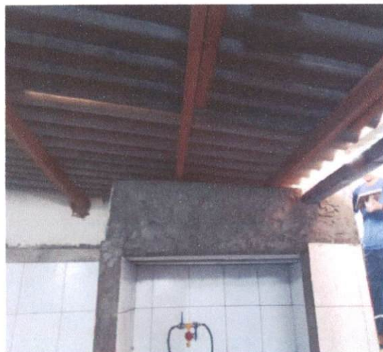
Item: 3.2.4 CHAPISCO APLICADO EM ALVENARIAS E ESTRUTURAS DE CONCRETO INTERNAS, COM COLHER DE PEDREIRO. ARGAMASSA TRAÇO 1:3 COM PREPARO MANUAL. AF_06/20 14
