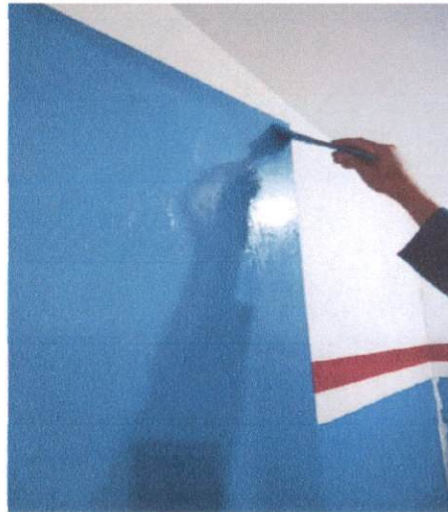
Item: 2.2.2 PINTURA TINTA DE ACABAMENTO (PIGMENTADA) A ÓLEO EM MADEIRA, 2 DEMÃOS. AF_01/2021
