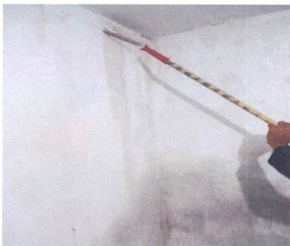
Ítem: 2.2.3 APLICAÇÃO MANUAL DE PINTURA COM TINTA LÁTEX ACRÍLICA EM PAREDES, DUAS DEMÃOS. AF_06/2014
