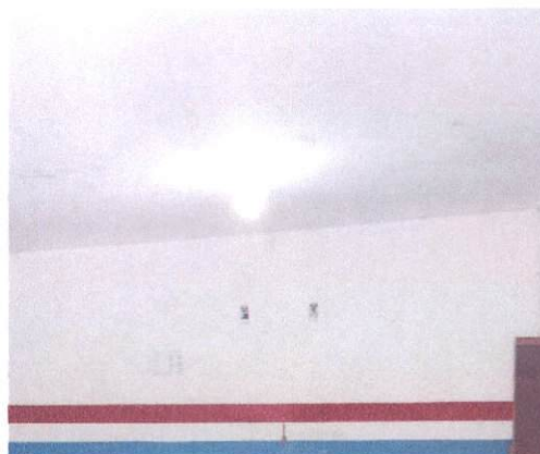
Item: 1.7.3.2 LUMINÁRIA TIPO PLAFON EM PLÁSTICO, DE SOBREPOR, COM 1 LÂMPADA FLUORESCENTE DE 15 W, SEM REATOR - FORNECIMENTO E INSTALAÇÃO. AF_02/2020
