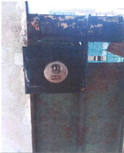
Item: 2.3.3 FECHADURA DE EMBUTIR COM CILINDRO, EXTERNA, COMPLETA, ACABAMENTO PADRÃO MÉDIO, INCLUSO EXECUÇÃO DE FURO - FORNECIMENTO E INSTALAÇÃO. AF_12/2019
