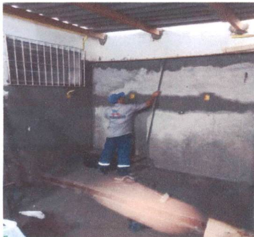
Item: 3.2.5 MASSA ÚNICA, PARA RECEBIMENTO DE PINTURA, EM ARGAMASSA TRAÇO 1:2:8, PREPARO MECÂNICO COM BETONEIRA 400L, APLICADA MANUALMENTE EM FACES INTERNAS DE PAREDES, ESPESSURA DE 20MM, COM EXECUÇÃO DE TALISCAS. AF_06/2014
