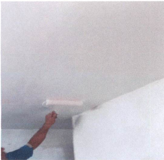
Item: 2.6.1.1 APLICAÇÃO DE FUNDO SELADOR ACRÍLICO EM TETO, UMA DEMÃO . AF_06/2014
