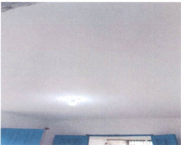
Item: 2.2.1 APLICAÇÃO MANUAL DE PINTURA COM TINTA LÁTEX ACRÍLICA EM TETO, DUAS DEMÃOS. AF_06/2014
