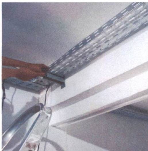
Item: 1.7.3.1 FORNECIMENTO E INSTALAÇÃO DE ELETROCALHA METÁLICA 38 x 76 MM
