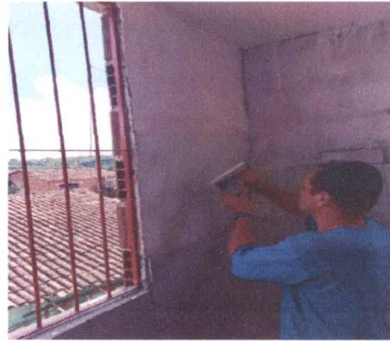
Item: 2.2.4 APLICAÇÃO E LIXAMENTO DE MASSA LÁTEX EM PAREDES, UMA DEMÃO. AF_06/2014 M2 CR
