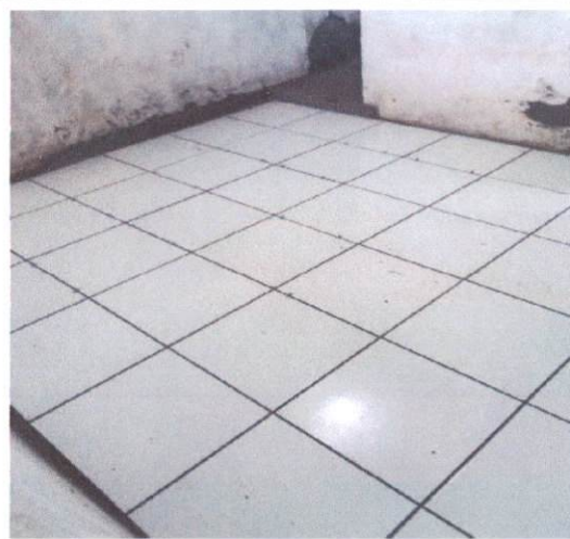
Item: 2.4.2 REVESTIMENTO CERAMICO PARA PISO COMPLACAS TIPO ESMALTADA EXTRA DE DIMENSÕES 35x35 CM APLICADA EM AMBIENTES DE ÁREA MAIOR QUE 10 M2 AF_06/2014
