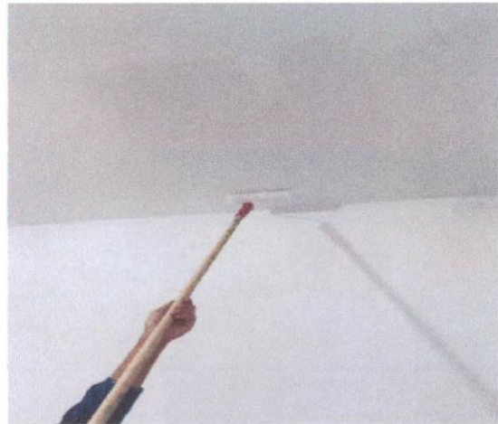
Item: 2.2.1 APLICAÇÃO MANUAL DE PINTURA COM TINTA LÁTEX ACRÍLICA EM TETO, DUAS DEMÃOS. AF_06/2014
