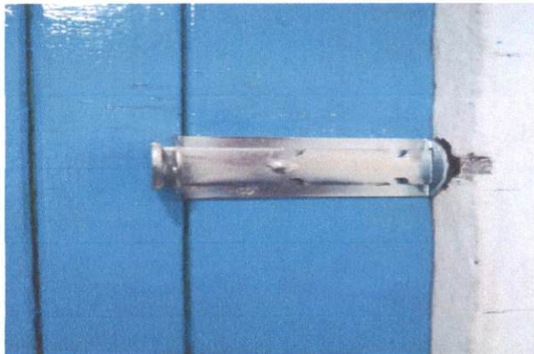
Item: 2.3.5 FERROLHO COM FECHO /TRINCO REDONDO, EM ACO GALVANIZADO / ZINCADO, DE SOBREPOR, COM COMPRIMENTO DE 10" A 12" E ESPESSURA MÍNIMA DA CHAPA DE 1,50 MM
