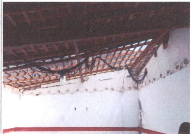
Item: 1.1.3 REMOÇÃO DE FORRO DE GESSO, DE FORMA MANUAL, SEM REAPROVEITAMENTO.
