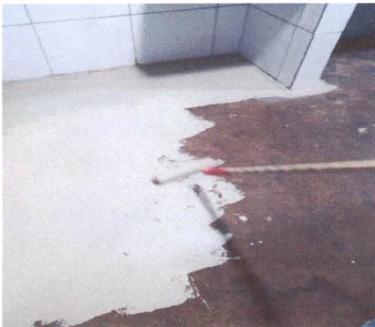
Ítem: 3.2.2 PINTURA DE PISO COM TINTA ACRILICA, APLICAÇÃO MANUAL, 2 DEMÃOS, INCLUSO FUNDO PREPARADOR AF_05/2021
