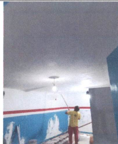
Item: 1.4.4 APLICAÇÃO MANUAL DE PINTURA COM TINTA LÁTEX ACRÍLICA EM PAREDES, DUAS DEMÃOS. AF_06/2014
