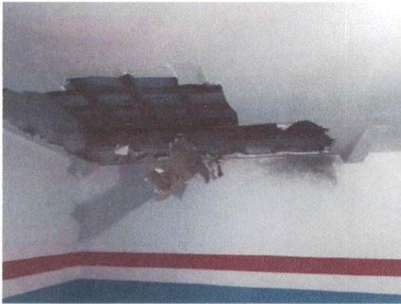
Item: 1.1.3 REMOÇÃO DE FORRO DE GESSO, DE FORMA MANUAL, SEM REAPROVEITAMENTO.
