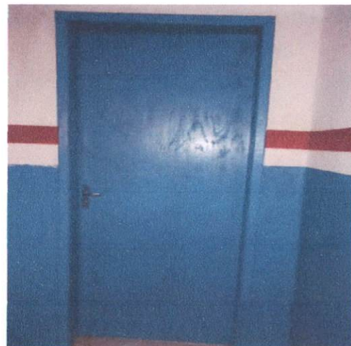
Item: 2.3.1 KIT DE PORTA DE MADEIRA PARA PINTURA, SEMI-OCA (PESADA OU SUPERPESADA), PADRÃO MÉDIO, 80X210CM, ESPESSURA DE 3,5CM, ITENS INCLUSOS: DOBRADIÇAS, MONTAGEM E INSTALAÇÃO DO BATENTE, FECHADURA COM EXECUÇÃO DO FURO -FORNECIMENTO E INSTALAÇÃO. AF_12/2019
