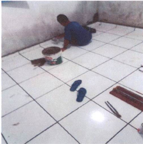
Item: 2.4.2 REVESTIMENTO CERÂMICO PARA PISO COM PLACAS TIPO ESMALTADA EXTRA DE DIMENSÕES 35x35 CM APLICADA EM AMBIENTES DE ÁREA MAIOR QUE 10 M2 AF_06/2014
