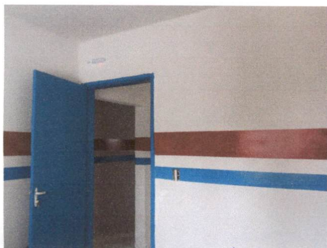
Foto 15: Aplicação de pintura interna, inclusive faixa com tinta acrílica e pintura das esquadrias com tinta a óleo. Comprova os Itens 6.1, 6.3, 6.4, 6.5 e 6.6
