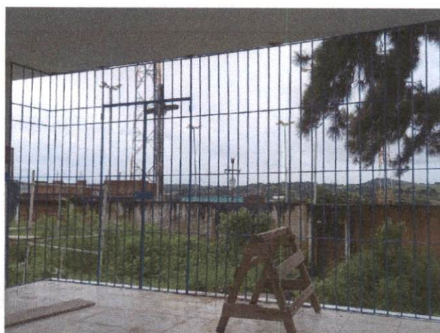
Foto 4: Fornecimento e assentamento de gradil e/ou portão, inclusive aparelhamento e pintura. Comprova o item 5.2.
