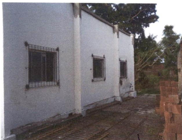
Foto 7: Fornecimento e assentamento de gradil e/ou portão, inclusive aparelhamento e pintura. Comprova o item 5.2.
