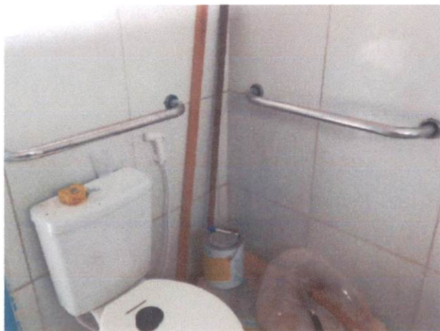
Foto 21: Barra de apoio. Comprova o item 7.4
