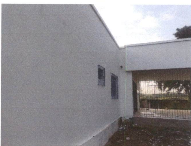
Foto 20: Aplicação de pintura externa e interna, inclusive faixa com tinta acrílica e pintura das esquadrias com tinta a óleo. Comprova os Itens 6.1, 6.3, 6.4, 6.5 e 6.6
