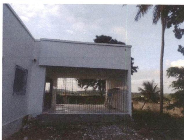
Foto 18: Aplicação de pintura externa e interna, inclusive faixa com tinta acrílica e pintura das esquadrias com tinta a óleo. Comprova os Itens 6.1, 6.3, 6.4, 6.5 e 6.6
