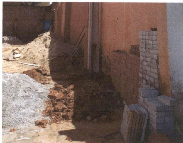
Foto 2: Transporte com carro de mão de areia, entulho ou terra até 30m. Comprova o item 1.4
