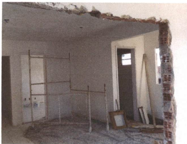
Foto 1: Transporte com carro de mão de areia, entulho ou terra até 30m. Comprova o item 1.4
