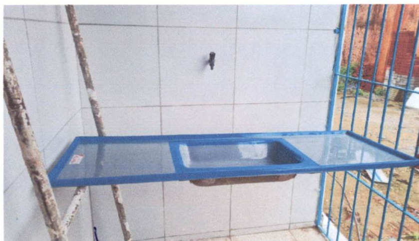
Foto 23: Bancada de mármore sintético, de 120 x 60 cm, com cuba integrada. Comprova o item 7.6.
