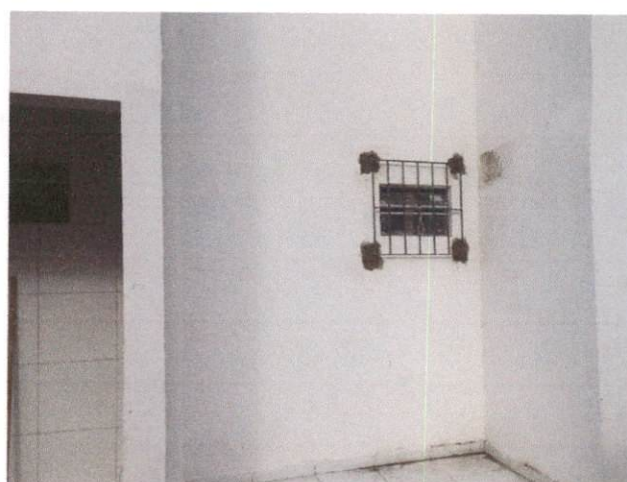
Foto 10: Aplicação de pintura externa e interna, inclusive faixa com tinta acrílica e pintura das esquadrias com tinta a óleo. Comprova os Itens 6.1, 6.3, 6.4, 6.5 e 6.6.
