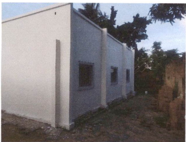
Foto 19: Aplicação de pintura externa e interna, inclusive faixa com tinta acrílica e pintura das esquadrias com tinta a óleo. Comprova os Itens 6.1, 6.3, 6.4, 6.5 e 6.6
