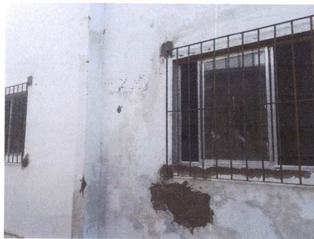
Foto 6: Fornecimento e assentamento de gradil e/ou portão, inclusive aparelhamento e pintura. Comprova o item 5.2.
