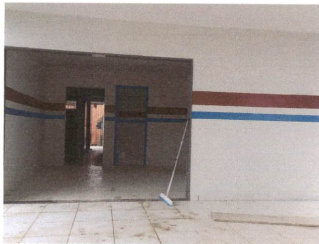
Foto 13: Aplicação de pintura interna, inclusive faixa com tinta acrílica e pintura das esquadrias com tinta a óleo. Comprova os Itens 6.1, 6.3, 6.4, 6.5 e 6.6
