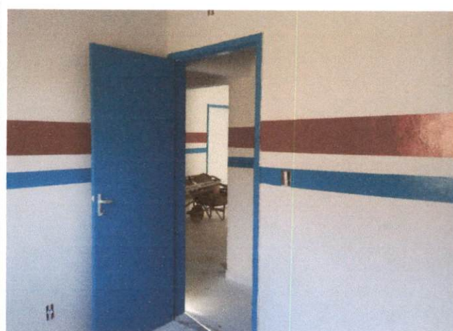
Foto 12: Aplicação de pintura interna, inclusive faixa com tinta acrílica e pintura das esquadrias com tinta a óleo. Comprova os Itens 6.1, 6.3, 6.4, 6.5 e 6.6.
