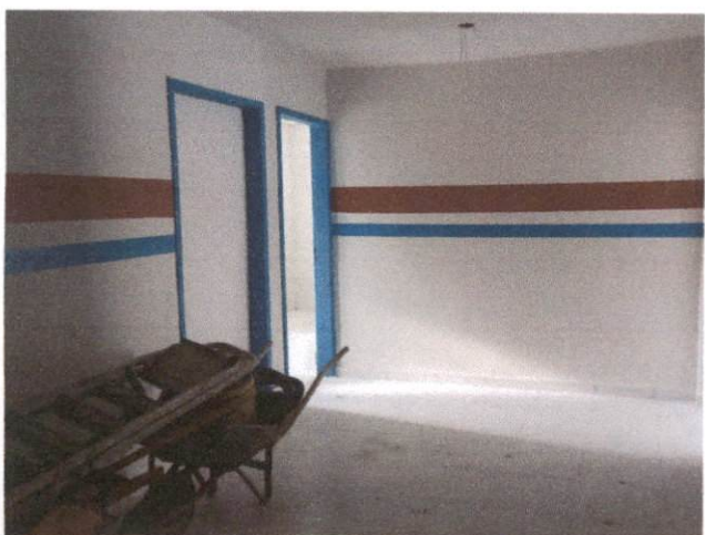
Foto 11: Aplicação de pintura interna, inclusive faixa com tinta acrílica e pintura das esquadrias com tinta a óleo. Comprova os Itens 6.1, 6.3, 6.4, 6.5 e 6.6.
