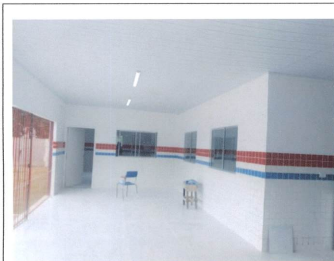
Foto 9: Aplicação manual de pintura em paredes, duas demãos, incluindo aplicação e lixamento de massa látex em paredes, duas demãos. (Item 8.1 e 8.2)
