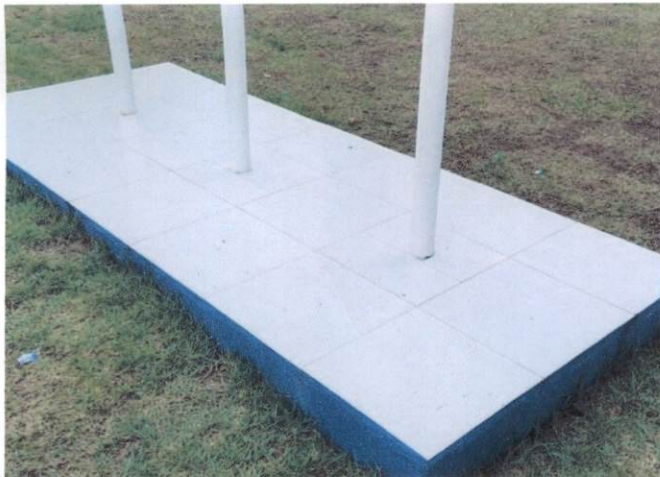
Foto 1: Revestimento cerâmico para piso com placas tipo esmaltada de dimensões 45 x 45 cm. (Item 5.2)
