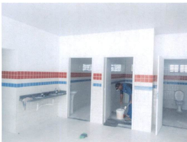
Foto 13: Aplicação manual de pintura em paredes, duas demãos, incluindo aplicação e lixamento de massa látex em paredes, duas demãos. (Item 8.1 e 8.2)
