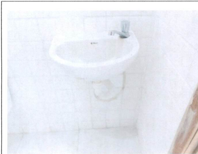
Foto 37: Lavatório louça branca suspenso. (Item 12.2.5)
