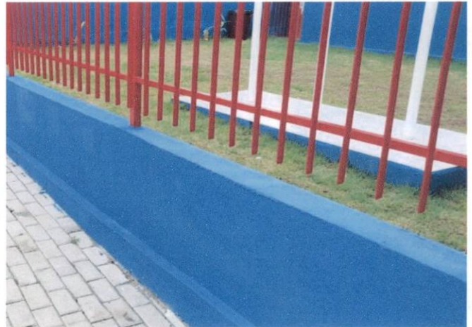
Foto 26: Aplicação manual de pintura com tinta texturizada em paredes externas. (Item 8.5)
