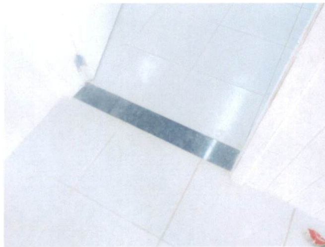
Foto 3: Soleira em granito, largura 15 cm, espessura 2,0 cm. (Item 5.3)
