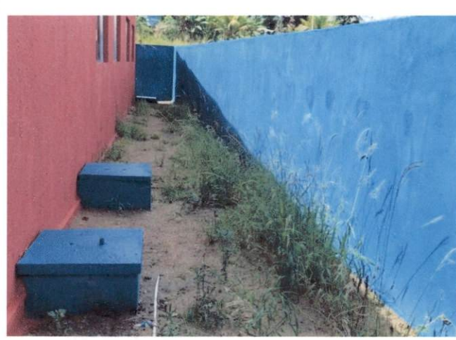
Foto 16: Aplicação manual de tinta látex acrílica em paredes externas. (Item 8.3)
