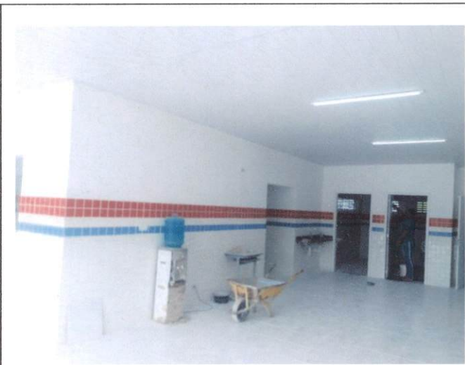
Foto 10: Aplicação manual de pintura em paredes, duas demãos, incluindo aplicação e lixamento de massa látex em paredes, duas demãos. (Item 8.1 e 8.2)
