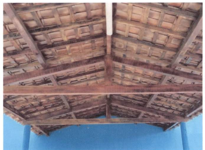
Foto 4: Trama de madeira composta por ripas, caibros e terças, incluindo telhamento com telha cerâmica capa-canal, tipo colonial. (Itens 6.2 e 6.3)
