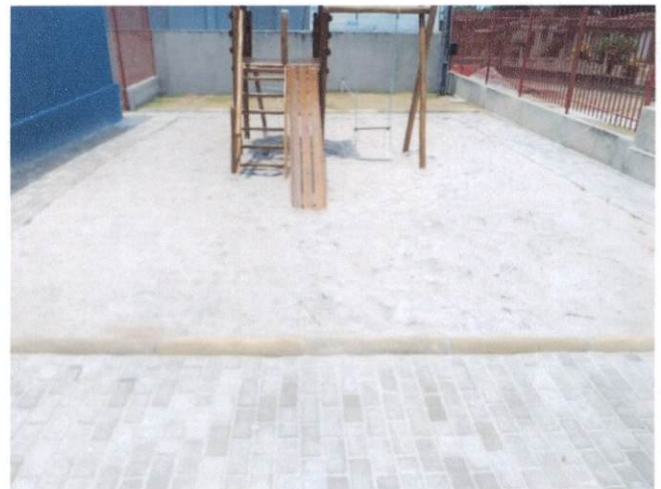
Foto 32: Colchão de areia. (Item 11.1)
