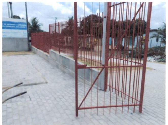
Foto 8: Gradil e/ou portão com ferragens inclusive aparelhamento e pintura com esmalte sintético duas demãos. (Item 7.2)
