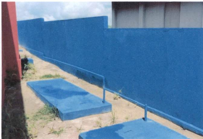
Foto 17: Aplicação manual de tinta látex acrílica em paredes externas. (Item 8.3)
