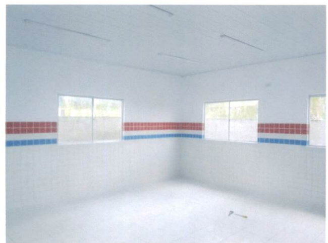
Foto 15: Aplicação manual de pintura em paredes, duas demãos, incluindo aplicação e lixamento de massa látex em paredes, duas demãos. (Item 8.1 e 8.2)
