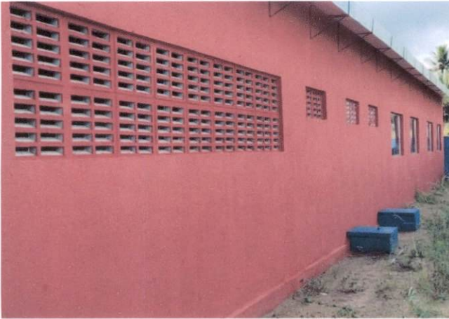
Foto 25: Aplicação manual de pintura com tinta texturizada em paredes externas. (Item 8.5)
