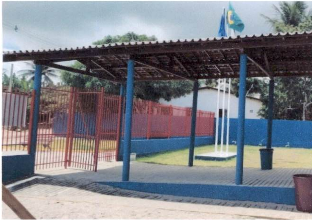
Foto 5: Trama de madeira composta por ripas, caibros e terças, incluindo telhamento com telha cerâmica capa-canal, tipo colonial. (Itens 6.2 e 6.3)
