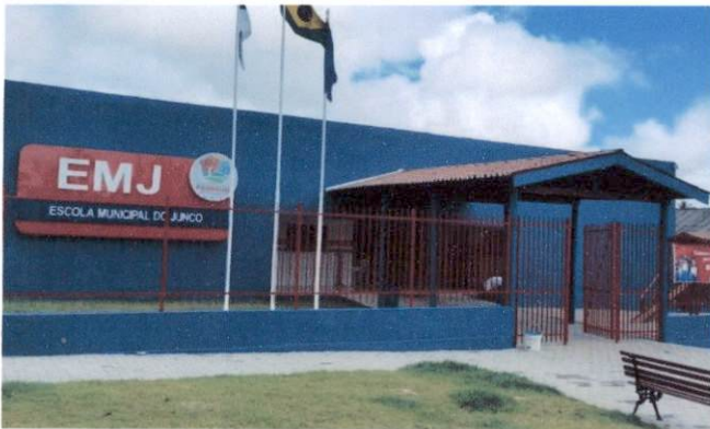
Foto 7: Gradil e/ou portão com ferragens inclusive aparelhamento e pintura com esmalte sintético duas demãos. (Item 7.2)
