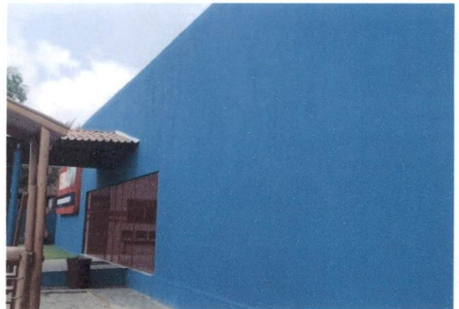
Foto 22: Aplicação manual de pintura com tinta texturizada em paredes externas. (Item 8.5)
