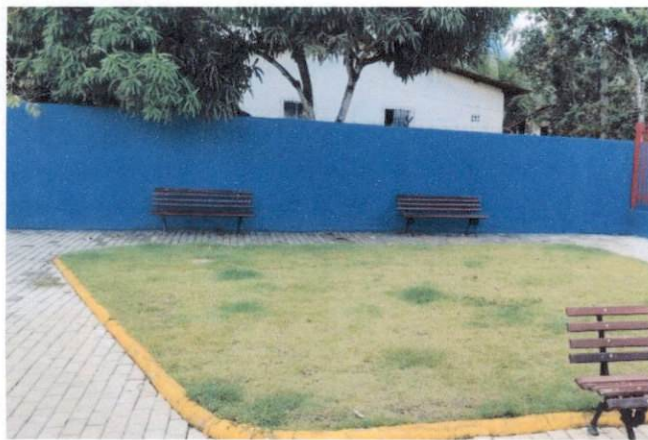
Foto 19: Aplicação manual de tinta látex acrílica em paredes externas. (Item 8.3)
