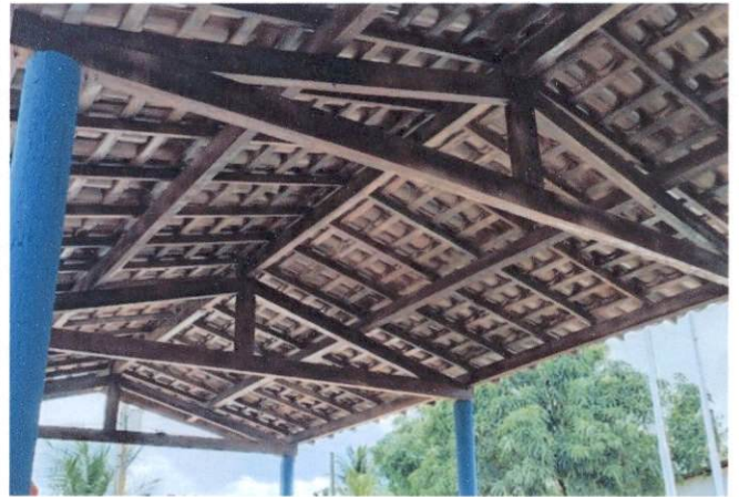
Foto 6: Fabricação e instalação de tesoura inteira em madeira. (Item 6.4)
