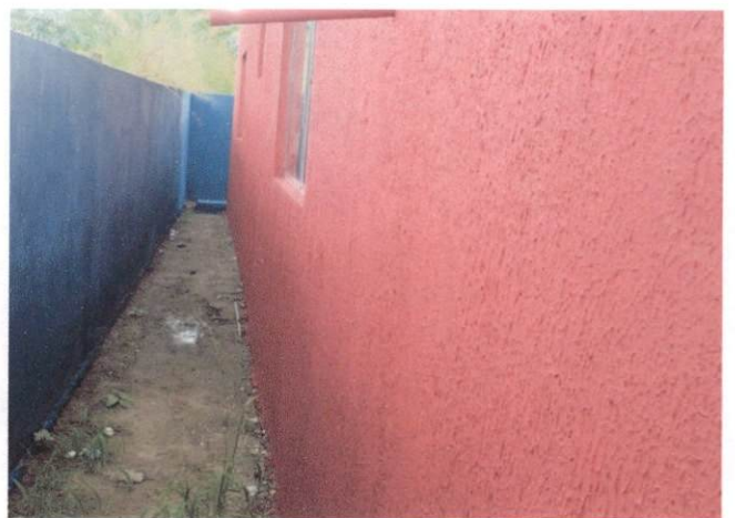
Foto 24: Aplicação manual de pintura com tinta texturizada em paredes externas. (Item 8.5)
