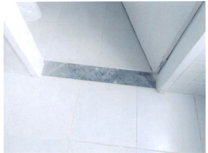
Foto 2: Soleira em granito, largura 15 cm, espessura 2,0 cm. (Item 5.3)
