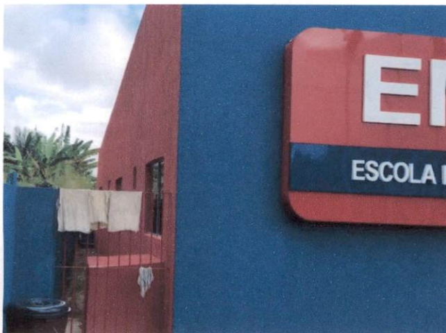
Foto 23: Aplicação manual de pintura com tinta texturizada em paredes externas. (Item 8.5)
