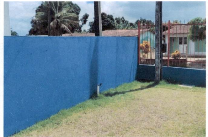
Foto 18: Aplicação manual de tinta látex acrílica em paredes externas. (Item 8.3)
