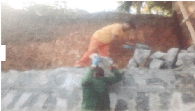
15.3.3 REVESTIMENTO COM ARGAMASSA DE CIMENTO E AREIA NO TRAÇO 1:3, COM 2,0 CM DE ESPESSURA.
