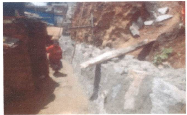
3.3.3 REVESTIMENTO COM ARGAMASSA DE CIMENTO E AREIA NO TRAÇO 1:3, COM 2,0 CM DE ESPESSURA.
