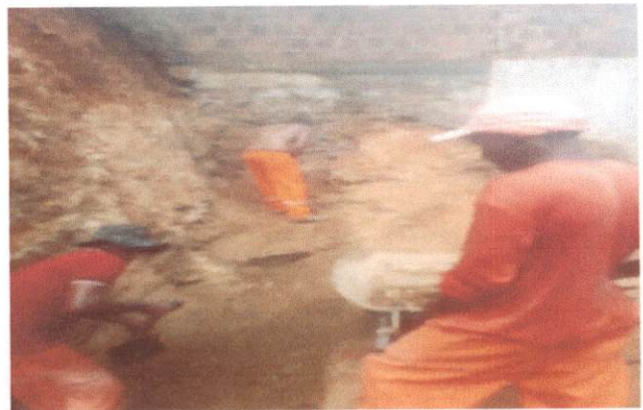
3.2.2 ESCAVAÇÃO MANUAL DE VALA COM PROFUNDIDADE MENOR OU IGUAL A 1,30 M. AF_02/2021
