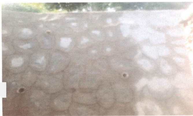
3.3.2 MURO DE ARRIMO DE ALVENARIA DE PEDRA ARGAMASSADA
