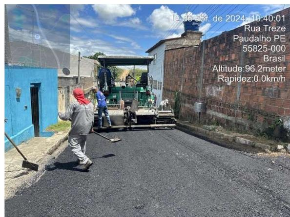
Item: 7.1.2 EXECUÇÃO DE PAVIMENTO COM APLICAÇÃO DE CONCRETO ASFÁLTICO, CAMADA DE ROLAMENTO - EXCLUSIVE CARGA E TRANSPORTE – RUA EDNALDO MENDES DE MOURA - SANTA MONICA
