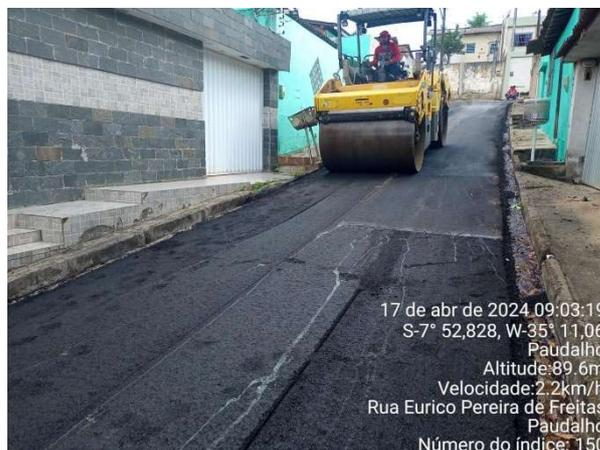
Item: 9.1.2 EXECUÇÃO DE PAVIMENTO COM APLICAÇÃO DE CONCRETO ASFÁLTICO, CAMADA DE ROLAMENTO - EXCLUSIVE CARGA E TRANSPORTE – RUA EURICO PEREIRA DE FREITAS - SANTA MONICA
