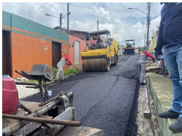
Item: 4.1.2 EXECUÇÃO DE PAVIMENTO COM APLICAÇÃO DE CONCRETO ASFÁLTICO, CAMADA DE ROLAMENTO - EXCLUSIVE CARGA E TRANSPORTE – – RUA ROSILDA FARIAS COSTA - SANTA MONICA
