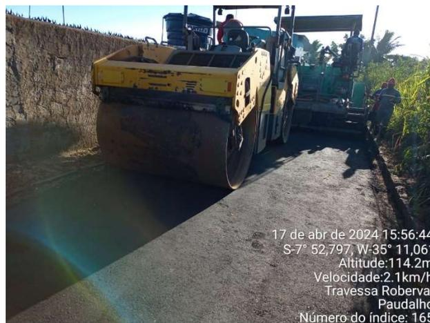
Item: 8.1.2 EXECUÇÃO DE PAVIMENTO COM APLICAÇÃO DE CONCRETO ASFÁLTICO, CAMADA DE ROLAMENTO - EXCLUSIVE CARGA E TRANSPORTE – TRAV ROBESVAL FELISMINO RAMOS - SANTA MONICA
