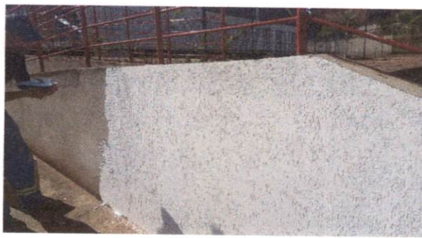
2.8.3.1 TEXTURA ACRÍLICA, APLICAÇÃO MANUAL EM PAREDE, UMA DEMÃO. AF_09/2016
