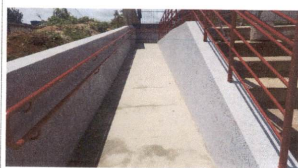
2.8.3.2 APLICAÇÃO MANUAL DE TINTA LÁTEX ACRÍLICA EM PAREDE EXTERNAS DE CASAS, DUAS DEMÃOS. AF_11/2016
