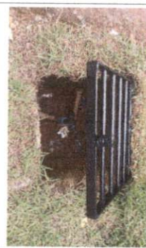
2.8.4.5 Grade de ferro para piso, articulável em dobradiça com fechamento em cadeado, em barra chata de 1 1/2" x 1/4" a cada 5,cm e cantoneira 2" x 1/4" de apoio
