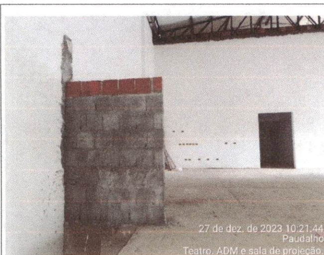
IMAGEM 13: CHAPISCO APLICADO EM ALVENARIAS E ESTRUTURAS DE CONCRETO, COM COLHER DE PEDREIRO, TRAÇO 1:3. COMPROVA O ITEM 4.3.
