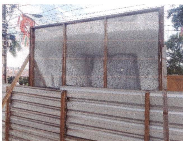
IMAGEM 2: FORNECIMENTO E INSTALAÇÃO DE PLACA DE OBRA EM CHAPA DE AÇO. COMPROVA OS ITEM 2.1.
