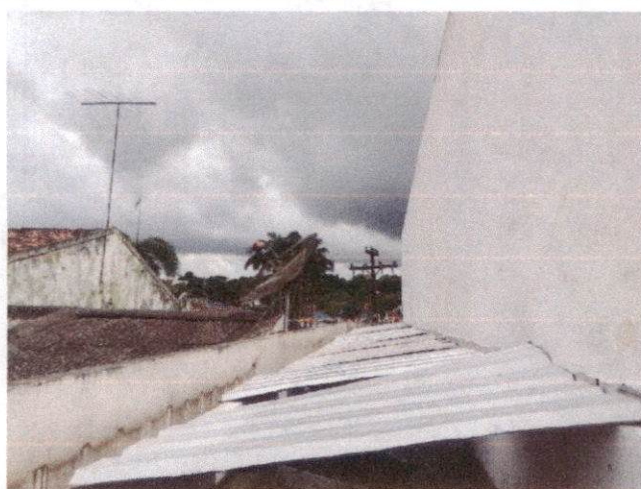
IMAGEM 7: REMOÇÃO DE TELHAS DE FIBROCIMENTO, METÁLICA E CERÂMICA, SEM REAPROVEITAMENTO. COMPROVA O ITEM 2.4.
