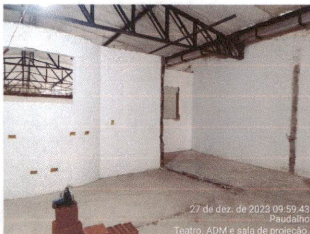
IMAGEM 3: DEMOLIÇÃO DE ALVENARIA DE BLOCO FURADO, DE FORMA MANUAL. COMPROVA OS ITEM 2.2.
