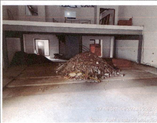
IMAGEM 9: CARGA, MANOBRA E DESCARGA DE ENTULHO. COMPROVA O ITEM 2.5.
