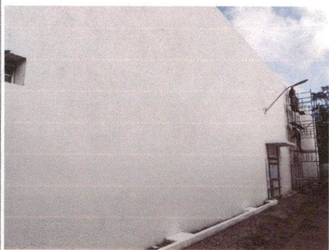
IMAGEM 23: APLICAÇÃO MANUAL DE PINTURA COM TINTA LÁTEX ACRÍLICA EM PAREDES, DUAS DEMÃOS. COMPROVA O ITEM 8.1.
