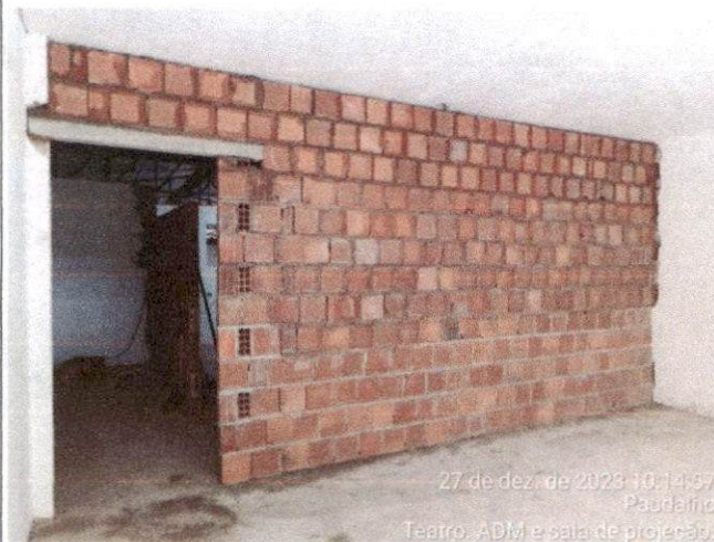
IMAGEM 11: ALVENARIA DE VEDAÇÃO DE BLOCOS CERÂMICOS FURADOS. COMPROVA O ITEM 4.1.
