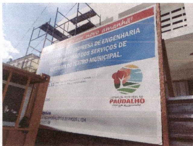
IMAGEM 1: FORNECIMENTO E INSTALAÇÃO DE PLACA DE OBRA EM CHAPA DE AÇO. COMPROVA OS ITEM 2.1.
