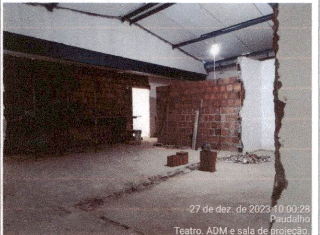
IMAGEM 12: ALVENARIA DE VEDAÇÃO DE BLOCOS CERÂMICOS FURADOS. COMPROVA O ITEM 4.1.
