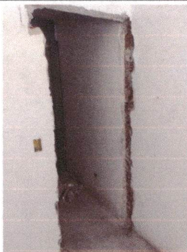
IMAGEM 5: REMOÇÃO DE PORTAS, DE FORMA MANUAL, SEM REAPROVEITAMENTO. COMPROVA O ITEM 2.3.
