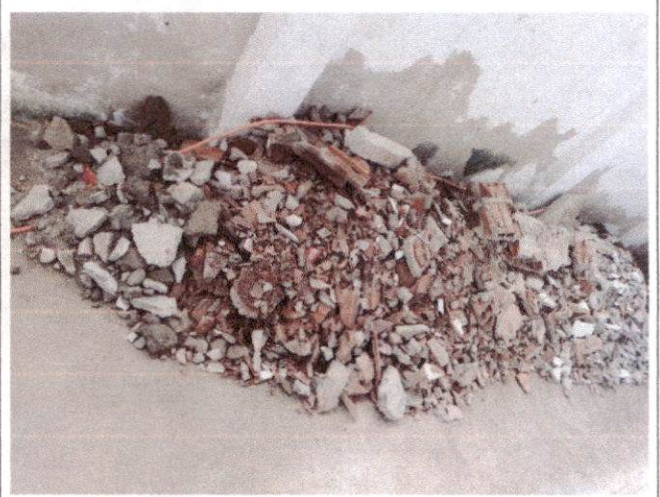
IMAGEM 10: CARGA, MANOBRA E DESCARGA DE ENTULHO. COMPROVA O ITEM 2.5.
