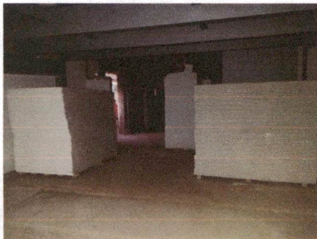
IMAGEM 17: PAREDE COM PLACAS DE GESSO ACARTONADO (DRYWALL), PARA USO INTERNO. COMPROVA O ITEM 4.6.
