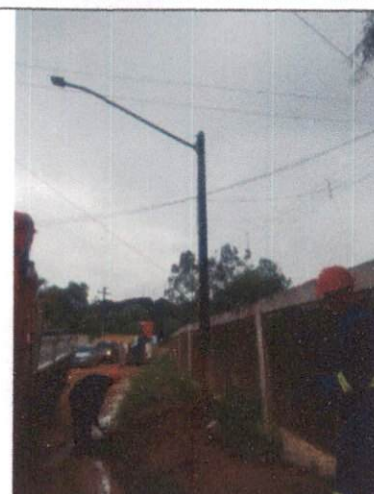
Foto 59: Assentamento de poste em Chã de Pinheiro.
