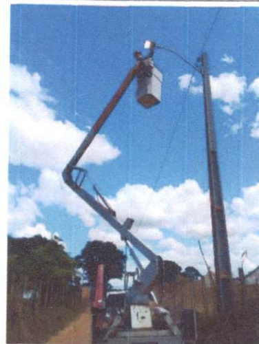
Foto 75: Instalação de luminária LED em Mussurepe.
