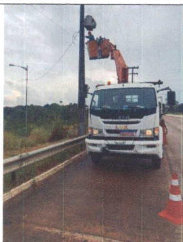
Foto 50: Extensão de rede IP na BR-408, próximo ao Bar da Tripa.
