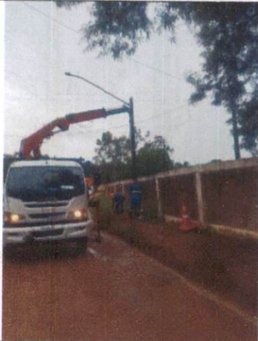
Foto 57: Assentamento de poste em Chã de Pinheiro.
