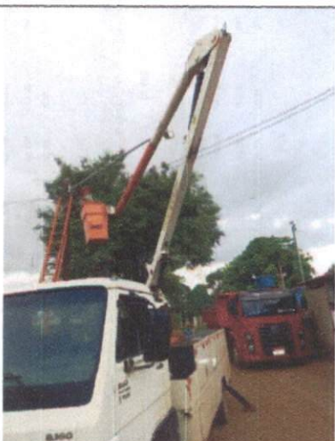
Foto 54: Instalação de luminária LED em Chã de Pinheiro.
