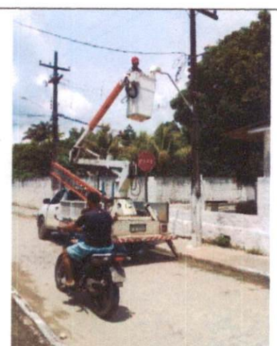
Foto 64: Instalação de luminária LED em Chã de Cruz.
