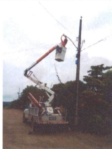
Foto 90: Instalação de luminária LED no Assentamento Chico Mendes.
