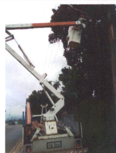
Foto 8: Instalação de luminária LED em Guadalajara.
