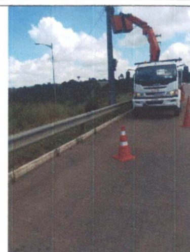
Foto 52: Extensão de rede IP na BR-408, próximo ao Bar da Tripa.
