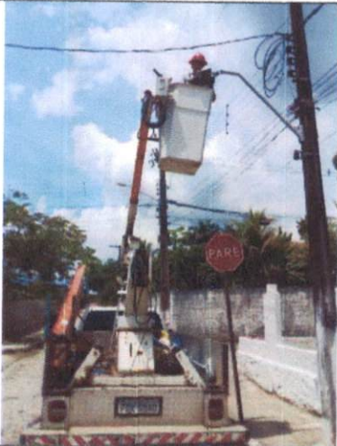
Foto 65: Instalação de luminária LED em Chã de Cruz.
