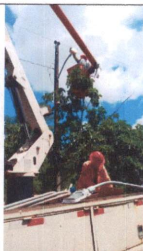
Foto 70: Instalação de luminária LED em Mussurepe.
