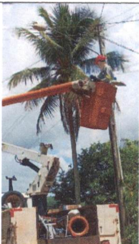
Foto 22: Instalação de luminária LED em Mussurepe.
