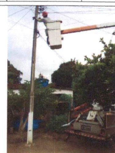
Foto 12: Instalação de luminária LED em Guadalajara.
