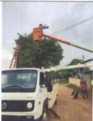
Foto 53: Instalação de luminária LED em Chã de Pinheiro.
