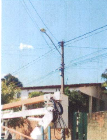
Foto 25: Instalação de luminária LED na Primavera.
