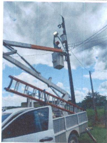
Foto 74: Instalação de luminária LED em Mussurepe.
