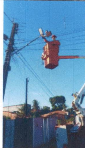
Foto 26: Instalação de luminária LED na Primavera.
