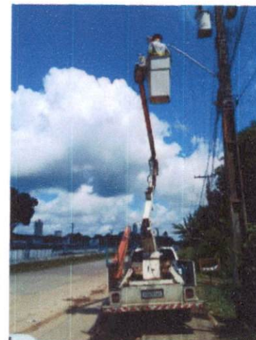
Foto 15: Instalação de luminária LED em Guadalajara.
