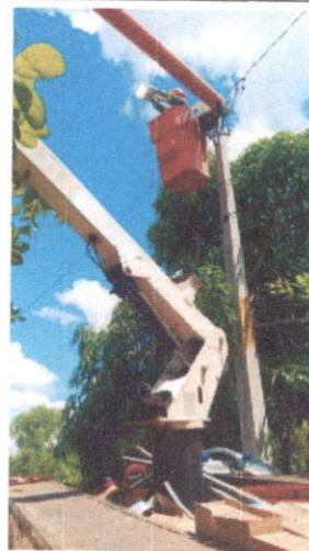
Foto 79: Instalação de luminária LED em Mussurepe.
