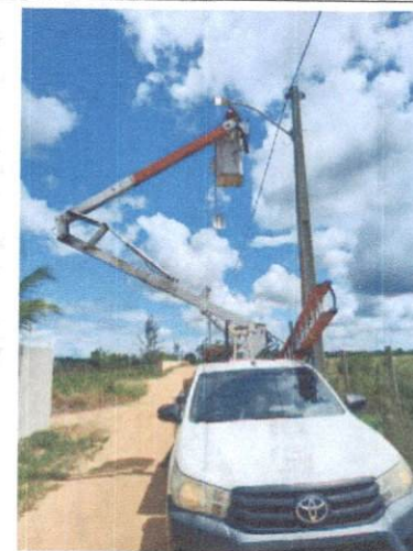
Foto 80: Instalação de luminária LED em Guadalajara, próximo ao Palavra da Vida.
