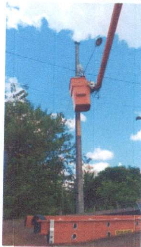
Foto 73: Instalação de luminária LED em Mussurepe.
