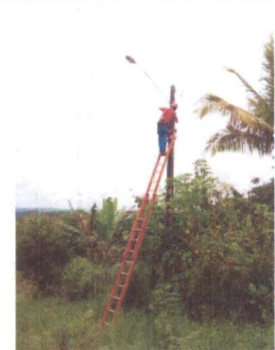
Foto 92: Instalação de luminária LED no Assentamento Chico Mendes.
