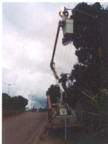
Foto 7: Instalação de luminária LED em Guadalajara.
