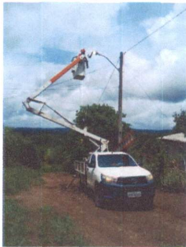
Foto 89: Instalação de luminária LED no Assentamento Chico Mendes.
