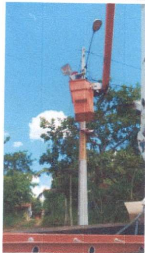
Foto 78: Instalação de luminária LED em Mussurepe.
