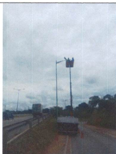
Foto 55: Extensão de rede IP e instalação de luminária LED na BR-408, próximo ao Bar da Tripa.
