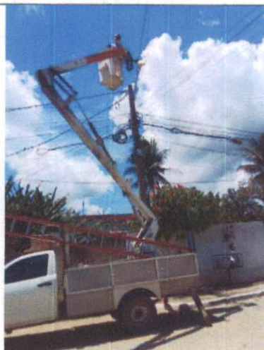
Foto 2: Instalação de luminária LED em Chã de Conselho.
