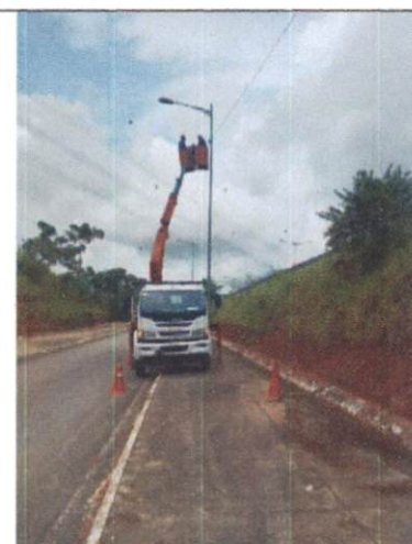
Foto 56: Extensão de rede IP e instalação de luminária LED na BR-408, próximo ao Bar da Tripa.
