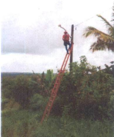
Foto 93: Instalação de luminária LED no Assentamento Chico Mendes.
