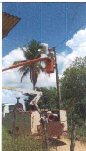
Foto 23: Instalação de luminária LED em Mussurepe.
