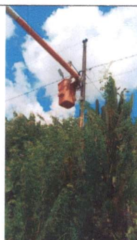
Foto 71: Instalação de luminária LED em Mussurepe.
