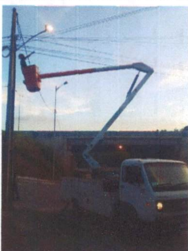
Foto 6: Instalação de luminária LED em Guadalajara.
