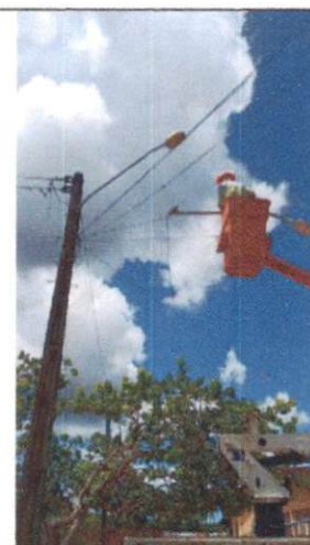
Foto 24: Instalação de luminária LED em Mussurepe.
