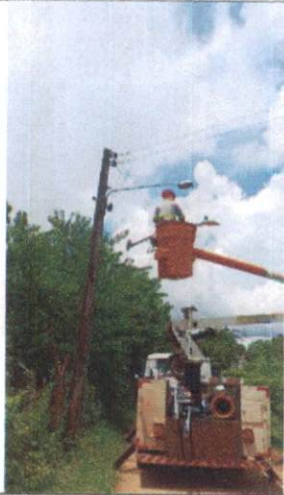
Foto 17: Instalação de luminária LED em Mussurepe.
