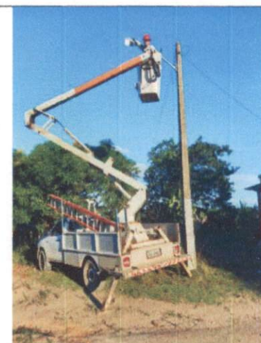
Foto 4: Instalação de luminária LED no Engenho Lavagem.
