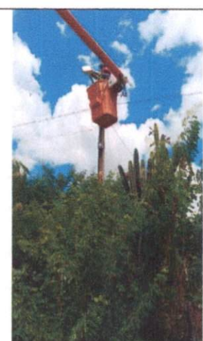
Foto 72: Instalação de luminária LED em Mussurepe.
