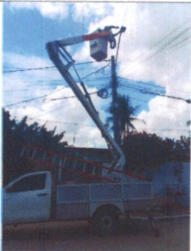
Foto 1: Instalação de luminária LED em Chã de Conselho.
