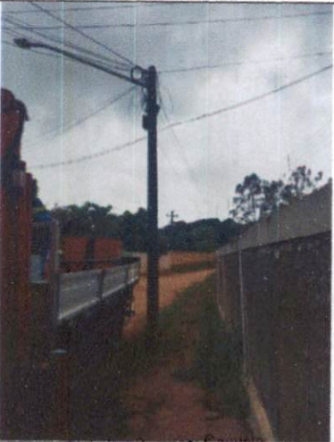
Foto 61: Assentamento de poste em Chã de Pinheiro.
