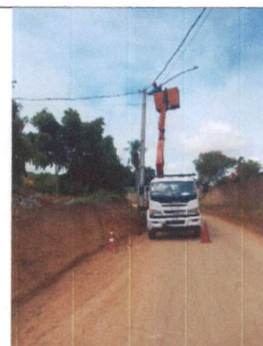
Foto 40: Instalação de luminária LED em Chã de Pinheiro.
