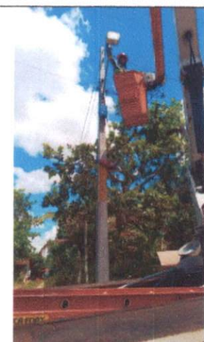
Foto 68: Instalação de luminária LED em Mussurepe.
