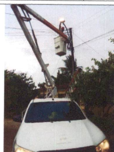
Foto 11: Instalação de luminária LED em Guadalajara.
