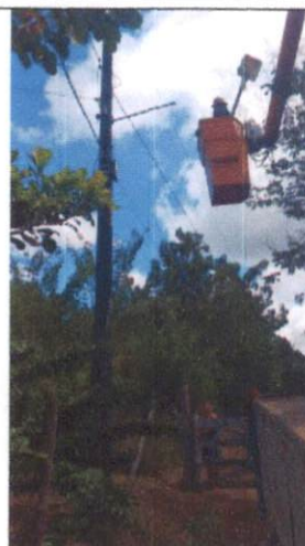
Foto 67: Instalação de luminária LED no Assentamento Chico Mendes.
