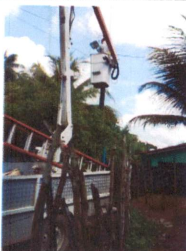
Foto 13: Instalação de luminária LED em Guadalajara.
