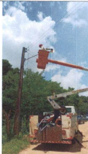
Foto 18: Instalação de luminária LED em Mussurepe.
