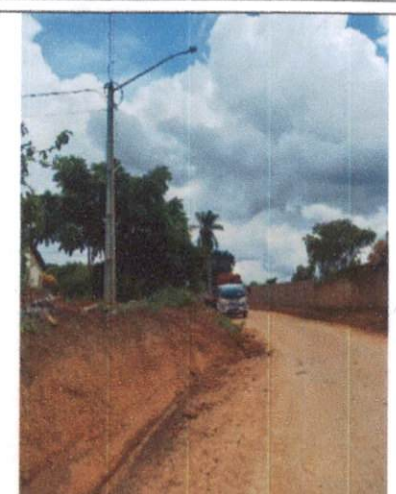
Foto 60: Assentamento de poste em Chã de Pinheiro.
