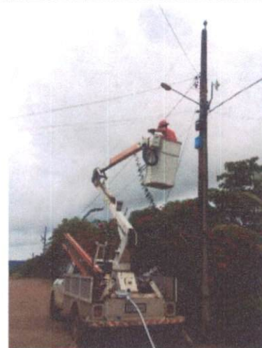
Foto 91: Instalação de luminária LED no Assentamento Chico Mendes.
