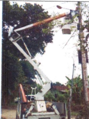
Foto 9: Instalação de luminária LED em Guadalajara.
