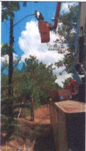
Foto 69: Instalação de luminária LED em Mussurepe.
