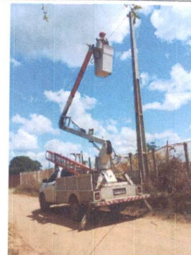
Foto 76: Instalação de luminária LED em Mussurepe.
