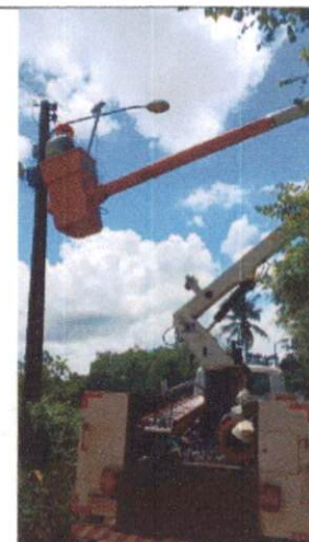
Foto 20: Instalação de luminária LED em Mussurepe.
