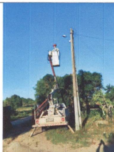
Foto 3: Instalação de luminária LED no Engenho Lavagem.
