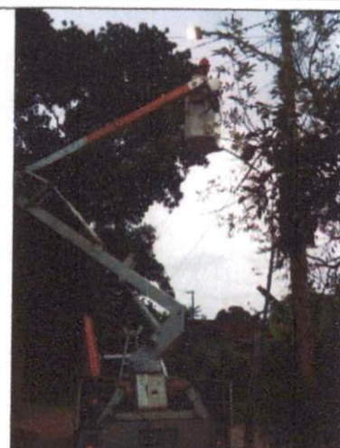
Foto 10: Instalação de luminária LED em Guadalajara.
