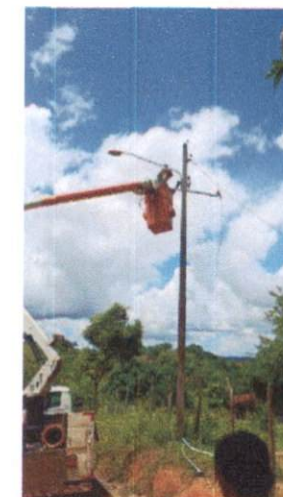
Foto 16: Instalação de luminária LED em Mussurepe.
