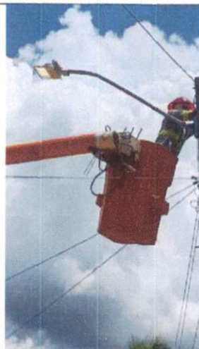
Foto 19: Instalação de luminária LED em Mussurepe.
