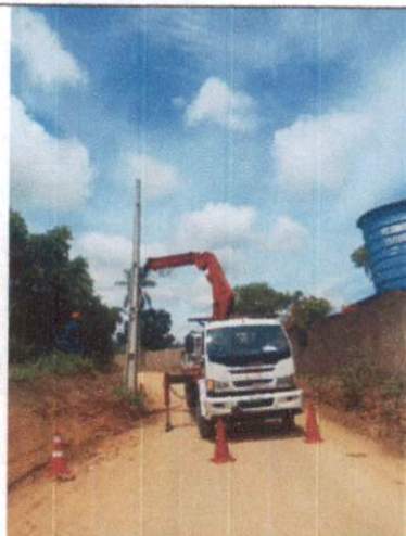
Foto 58: Assentamento de poste em Chã de Pinheiro.
