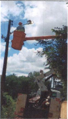
Foto 21: Instalação de luminária LED em Mussurepe.
