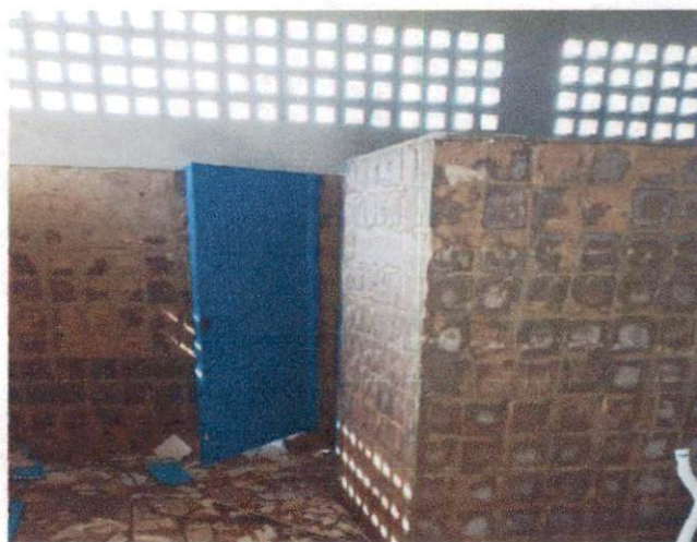
Descrição: ITEM 2.3 – DEMOLIÇÃO DE REVESTIMENTO CERÂMICO
