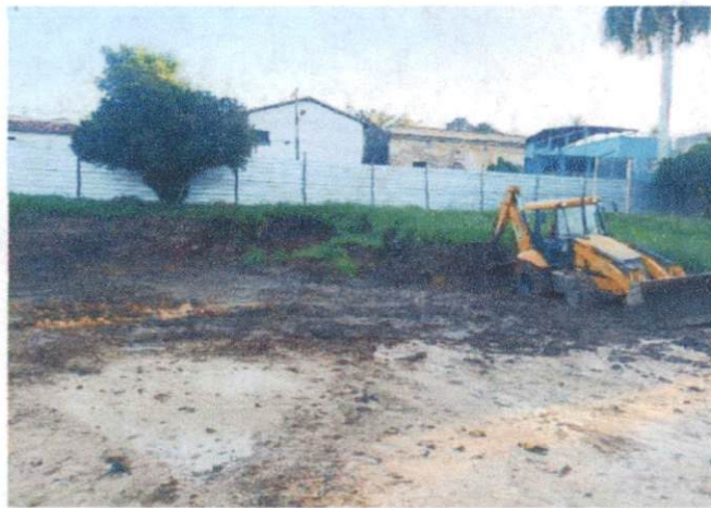
Descrição ITEM 3.5 – ESCAVAÇÃO VERTICAL
