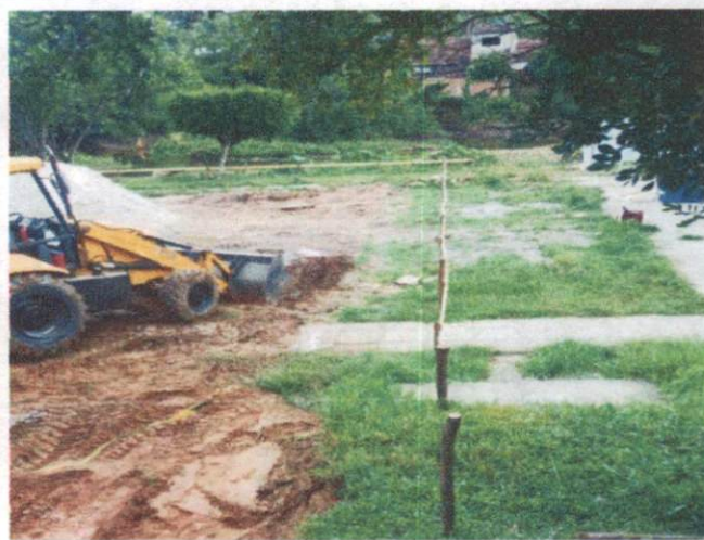
Descrição: ITEM 1.3 – LOCAÇÃO CONVECIONAL DE OBRA
