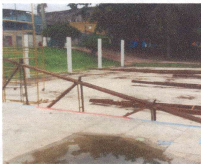
Descrição: ITEM 2.2 – DEMOLIÇÃO DE PILARES E VIGAS
