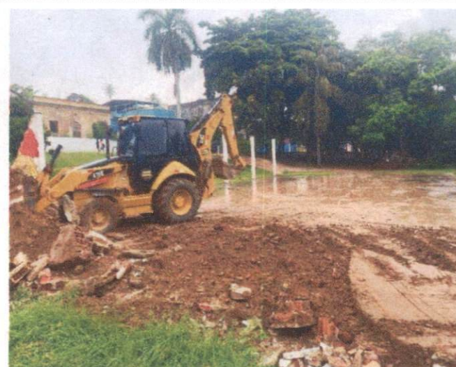
Descrição: ITEM 2.2 – DEMOLIÇÃO DE PILARES E VIGAS
