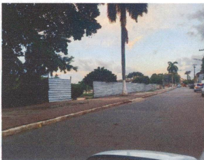
Descrição: ITEM 1.2 – TAPUME COM TELHA METÁLICA
