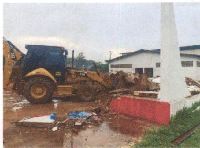
Descrição: ITEM 2.1 – DEMOLIÇÃO DE ALVENARIA
