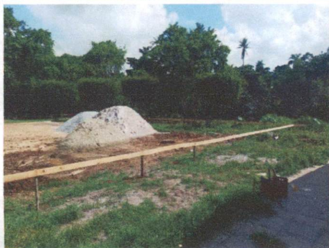
Descrição: ITEM 1.3 – LOCAÇÃO CONVECIONAL DE OBRA
