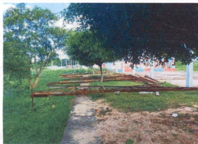
Descrição: ITEM 2.5 – REMOÇÃO DE TRAMA METÁLICA PARA COBERTURA
