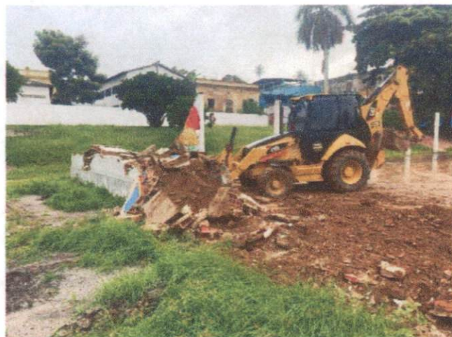
Descrição: ITEM 2.1 – DEMOLIÇÃO DE ALVENARIA
