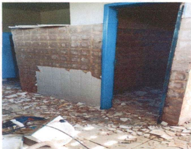
Descrição: ITEM 2.3 – DEMOLIÇÃO DE REVESTIMENTO CERÂMICO
