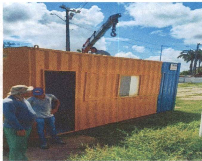
Descrição: ITEM 1.4 – LOCAÇÃO DE CONTAINER
