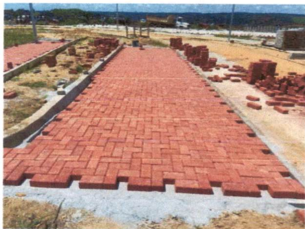
Item: 1.3.1 - EXECUÇÃO DE PÁTIO/ESTACIONAMENTO EM PISO INTERTRAVADO, COM BLOCO RETANGULAR COLORIDO DE 20 X 10 CM, ESPESSURA 8 CM. AF_12/2015
