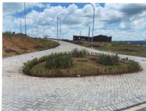
Item: 1.3.2 - EXECUÇÃO DE PÁTIO/ESTACIONAMENTO EM PISO INTERTRAVADO, COM BLOCO RETANGULAR COR NATURAL DE 20 X 10 CM, ESPESSURA 8 CM. AF_12/2015
