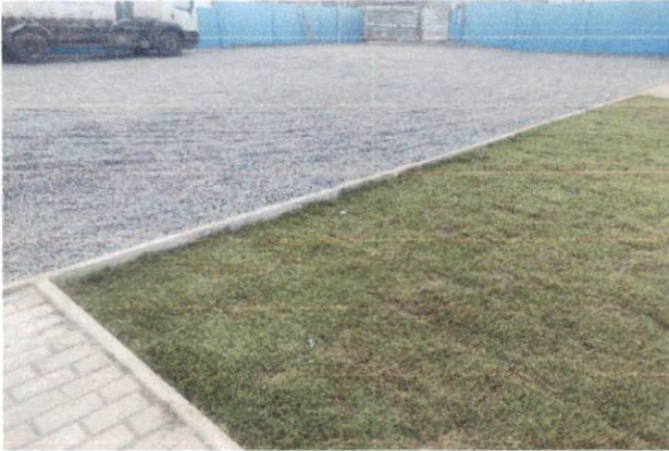
10.2.3 Meio-fio concreto, moldado in loco, 11,5cm base x 22cm altura 10.2.4 Ladro de beira para o estacionamento
