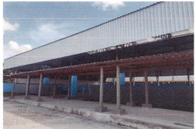
7.2 Cobertura em telha metálica trapezoidal
