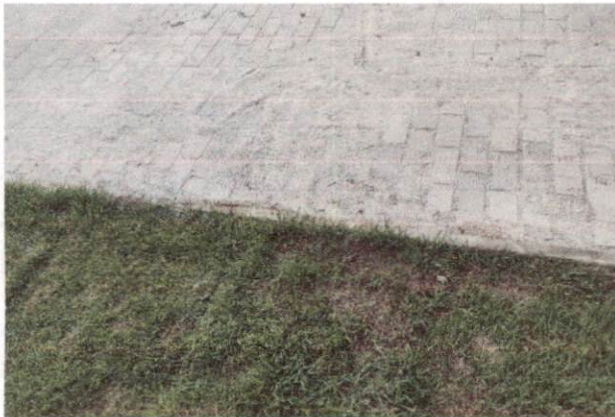
10.2.5 Pavimentação em blocos intertravado de concreto, assentados sobre colchão de areia
