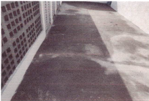
10.1.2 Piso cimentado desempenado com acabamento liso e=2,0cm com junta plastica acabada 1,2m
