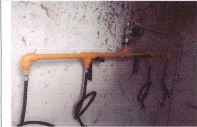
15.1 Quadro para ventilação em chapa de alumínio com veneziana
