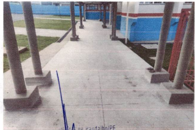
10.1.7 Piso em granilite, inclusive (Piso em instalação plastica) Tel. 44-498
