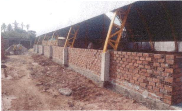
5.2.1 Alvenaria de vedação de 1/2 em tijolos ceramicos (dimensões normais: 39x19x19); assentamento em argamassa no gtreço 1:2:8 ( cimento, cal e areia)
