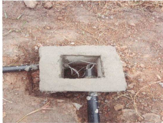
17.2.7 Eletroduto PVC rígido roscavel 60mm 2 (2")
