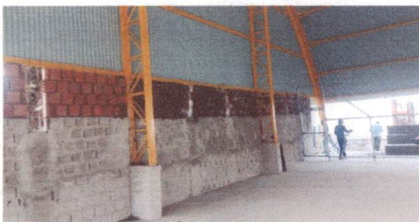
9.1.1 Chapisco em parede interna com argamassa traço 1:3 (cimento e areia) Frontal
