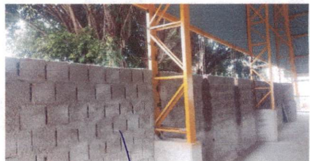
9.1.1 Chapisco em parede interna com argamassa traço 1:3 (cimento e areia) Frontal
