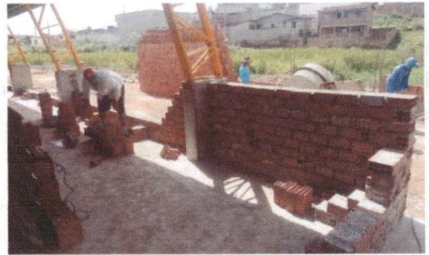
5.2.1 Alvenaria de vedação de 1/2 em tijolos ceramicos (dimensões normais: 39x19x19); assentamento em argamassa no gtreço 1:2:8 ( cimento, cal e areia)
