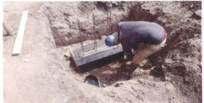
8.1 IMPERMEABILIZAÇÃO COM Mulsão ASFALTICA 2 DEMÃO BALDRAMES
