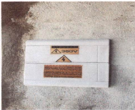
17.1.1 Quadro de distribuição de energia para 18 djntores
